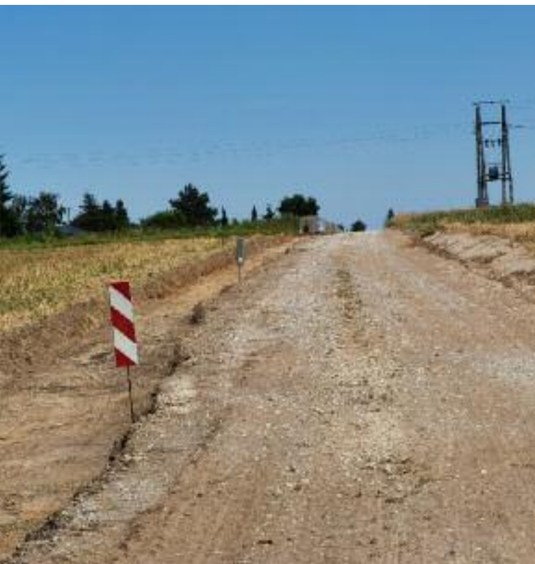
7. Przebudowa drogi w Strzeszkowicach
